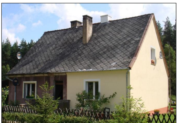
Fot. 2 Płyty azbestowo-cementowe płaskie
