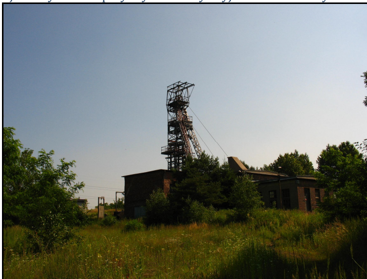
Ilustracja 6 – zdjęcie stacji wentylatorów przy szybie Wentylacyjno-Podsadzkowym w Radzionkowie
